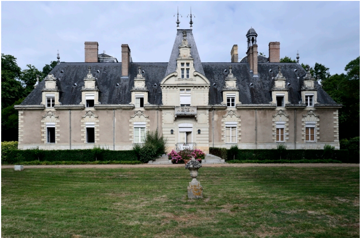
Vue de la façade est.
