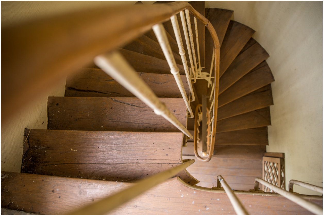
L'escalier de l'ancienne gendarmerie.
