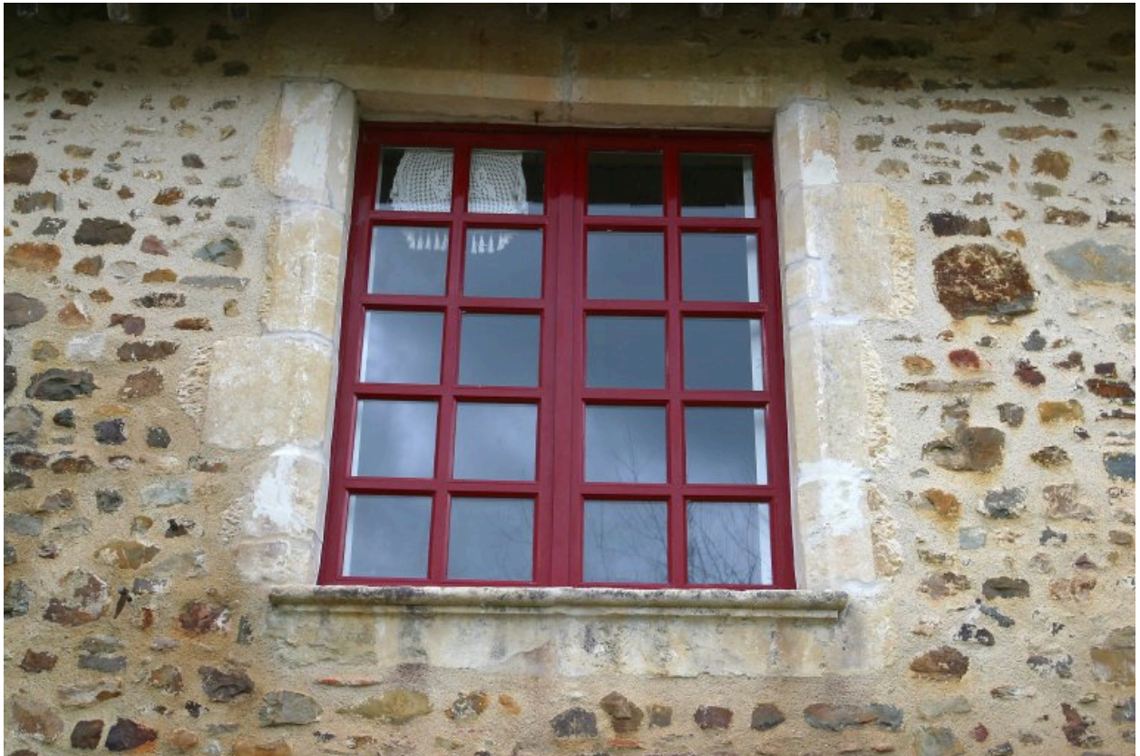
Détail de la façade principale du corps de bâtiment nord-est : fenêtre gauche du premier étage.
