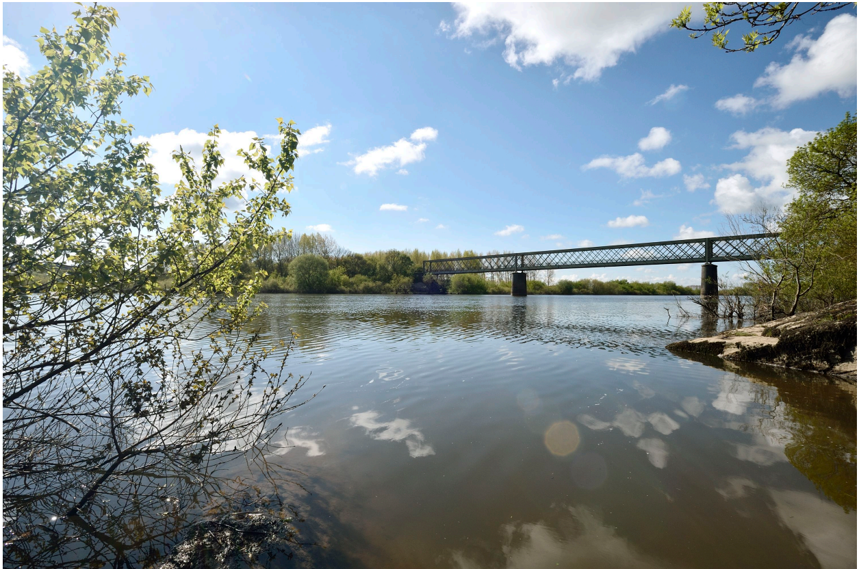
Vue du pont depuis la rive ouest.
