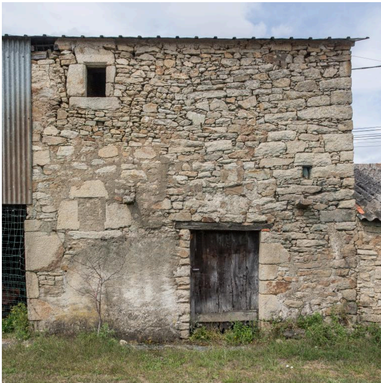
Habitation à deux niveaux. XVe siècle ?. Beaulieu, Saint-Hilaire-de-Clisson. Cadastre 2018, ZA 01-273.
