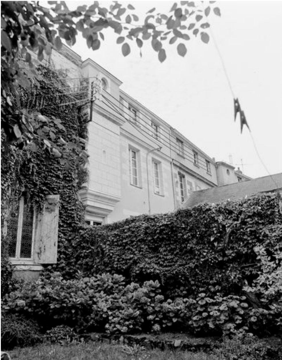
Aile sud du logement des religieux : façade ouest sur jardin remployée dans un lotissement de demeures : vue des parties hautes aux 16 et 18 quai des Carmes.
