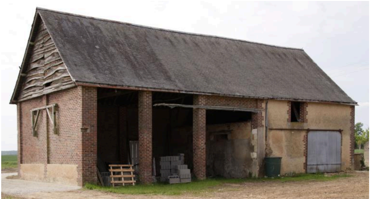
Hangar-écurie : façade antérieure sur cour.
