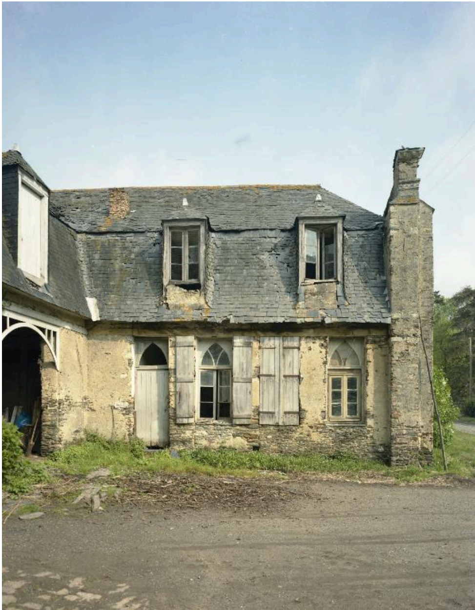
Bâtiment ouest, façade sud, fenêtre en ogive (1984).
