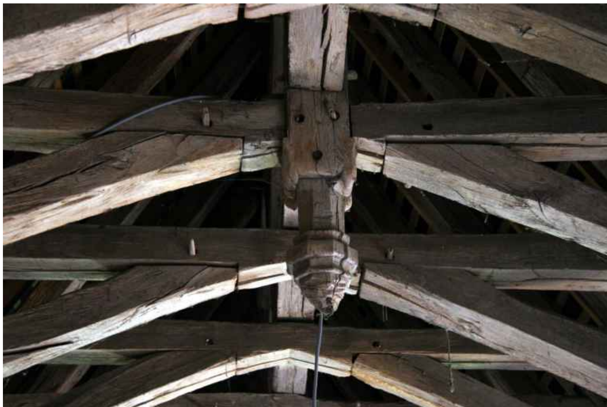
Le logis, charpente : détail.
