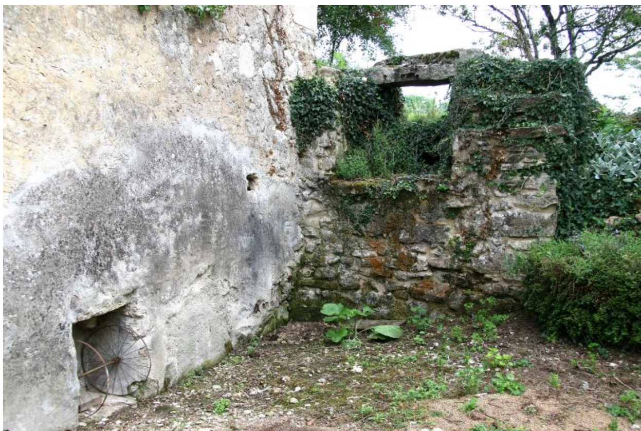
Pignon du moulin : chute d'eau.
