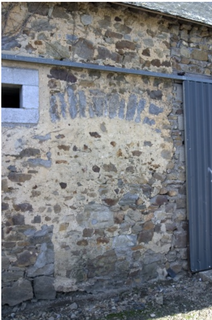
Porte bouchée sur la façade principale de l'étable.
