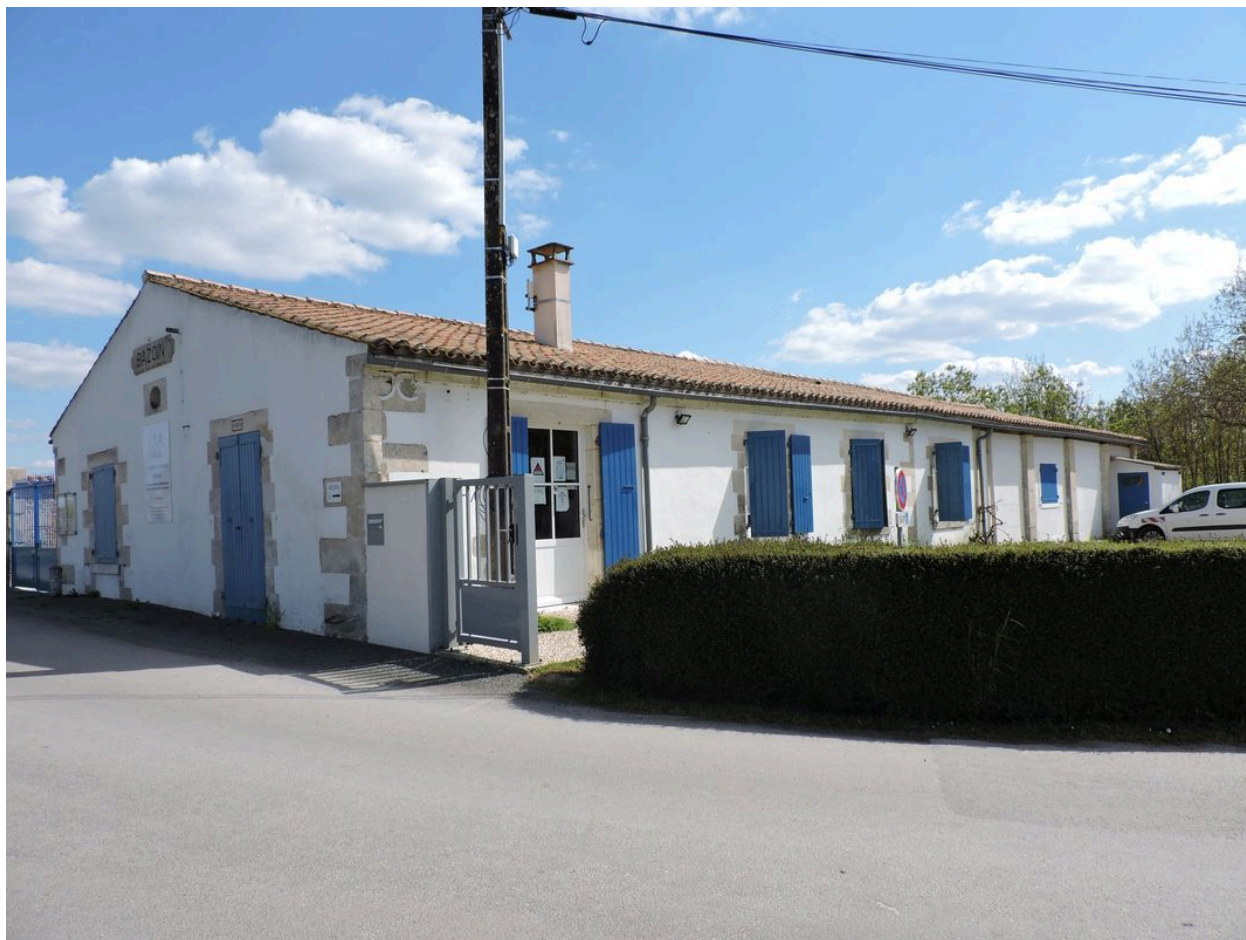
La maison éclusière vue depuis le nord-ouest.
