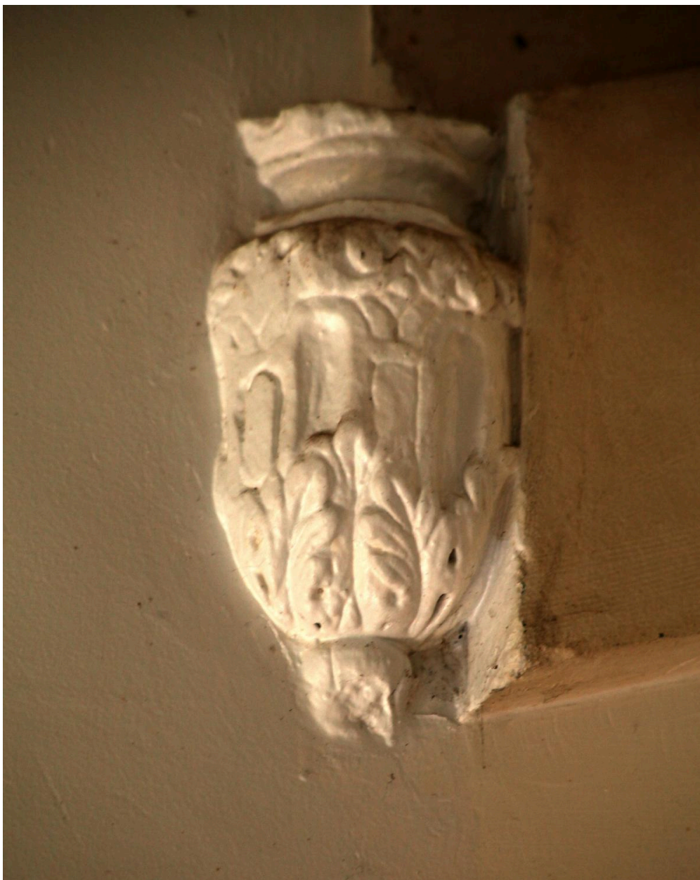
Rez-de-chaussée, voûte du vestibule : culot 5.
