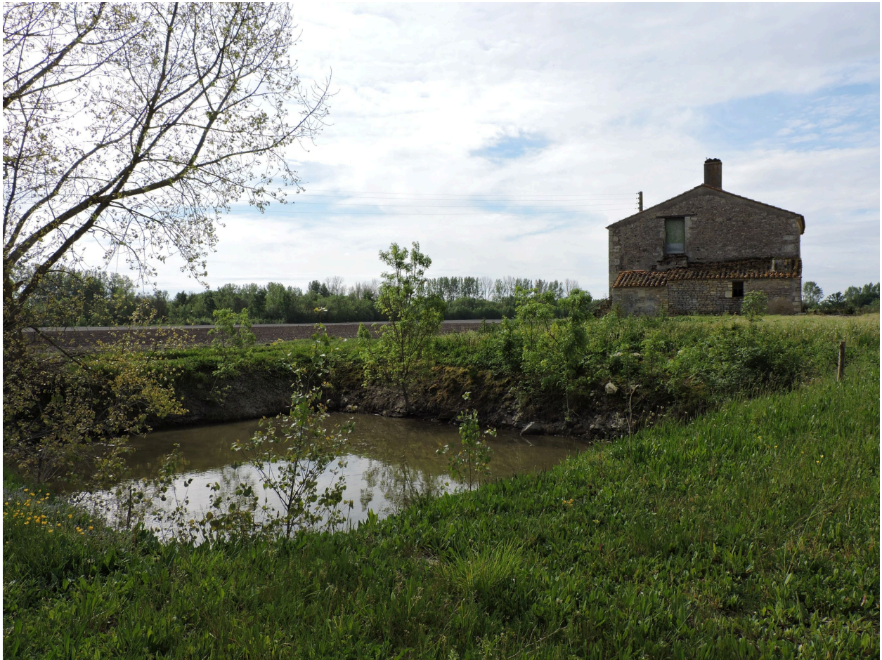
La mare au nord-est des bâtiments.
