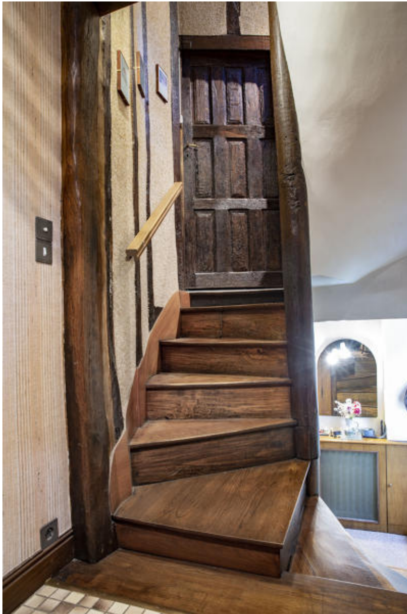
Vue de l'escalier en vis en bois depuis le palier du niveau intermédiaire.
