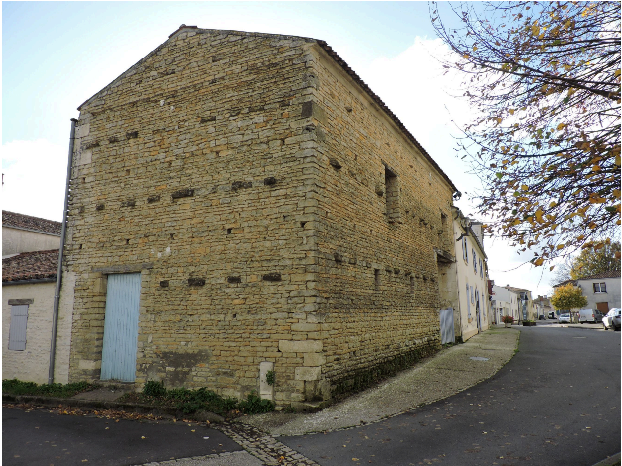
Les dépendances vues depuis le nord-est.
