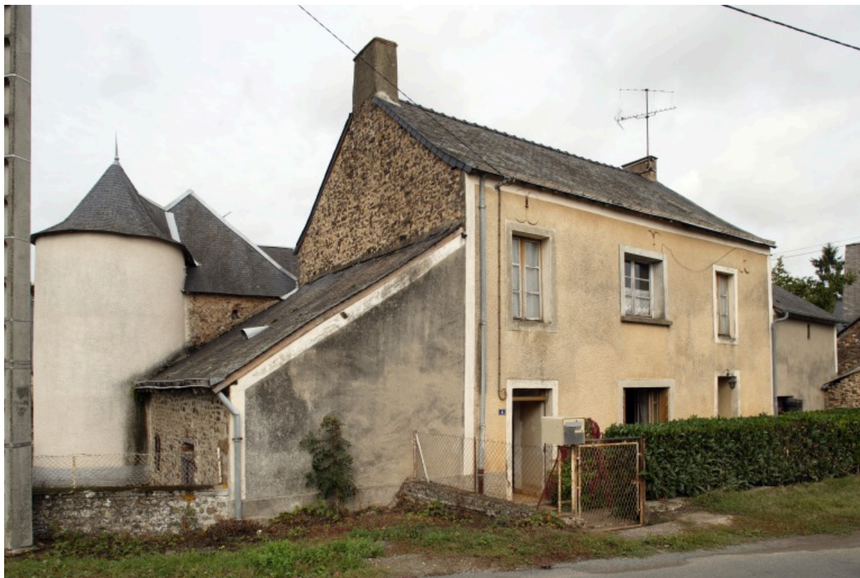
Vue d'ensemble depuis la route.
