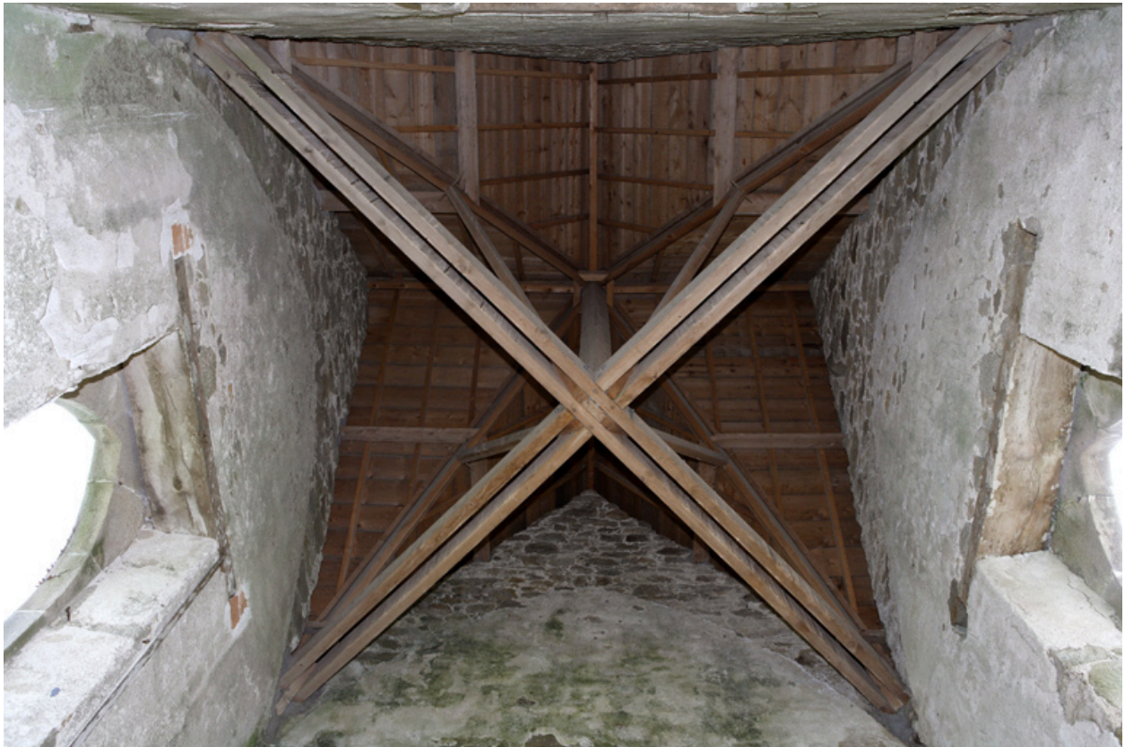
Chapelle. Détail de la charpente.
