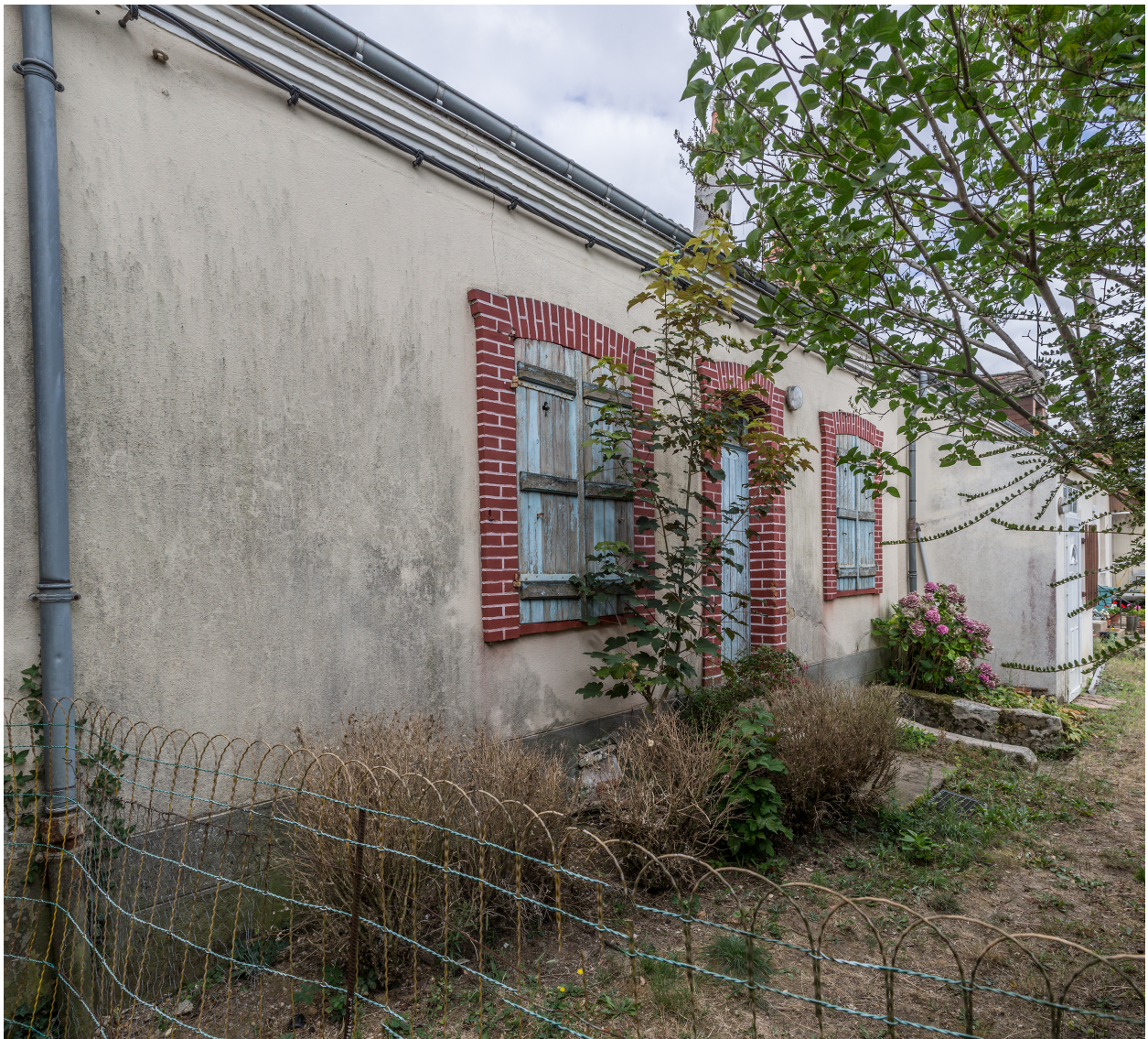
Une maison de tisserand, rue de Belfort.
