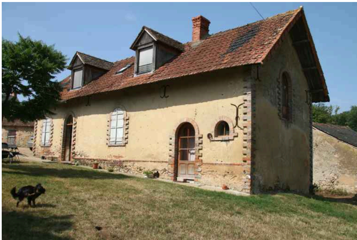
Maison n°5 : maison du garde de la Roltièr.
