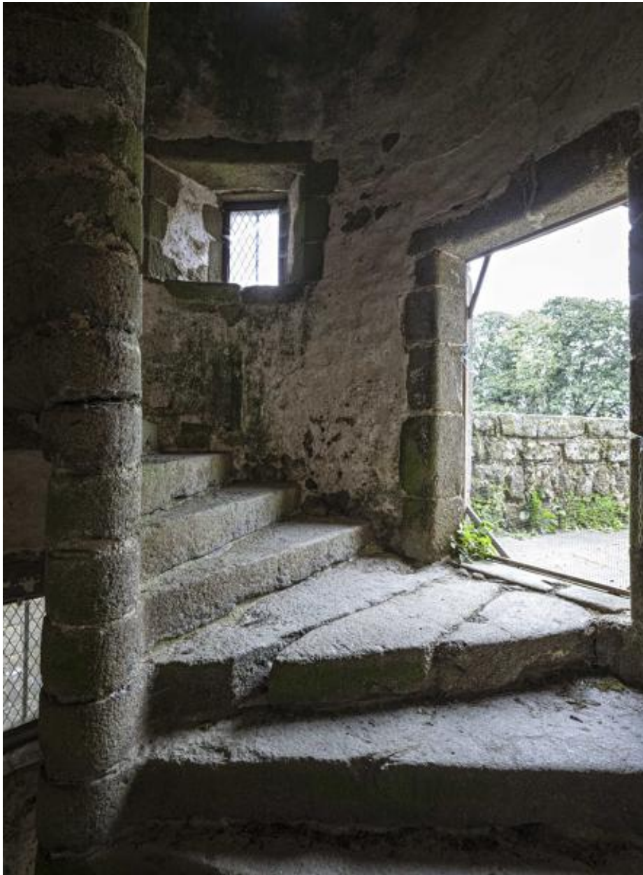
Escalier du corps de logis sud.
