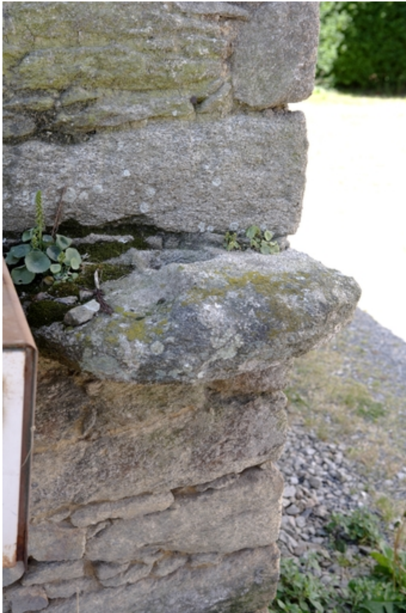
Remise. Pierre percée destinée à la fixation d'une barrière.
