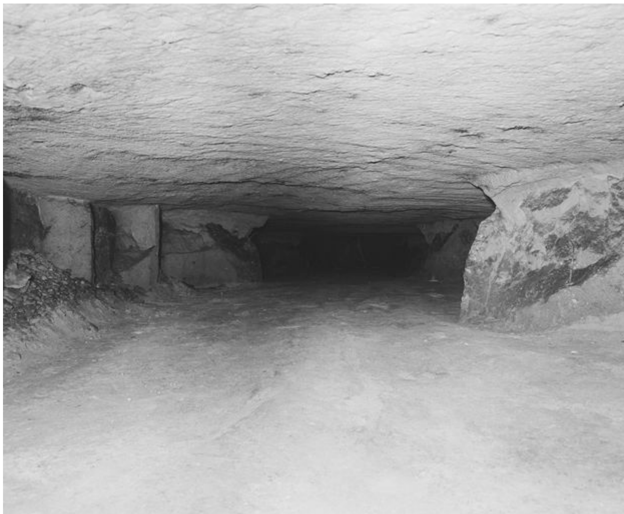
Carrière des Roches, large galerie d'extraction.
