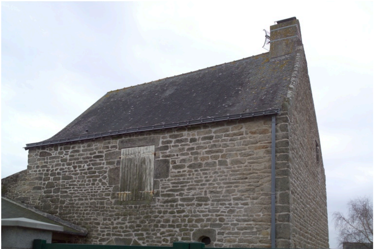
Maison parcelle AH 271, vue vers le Sud.
