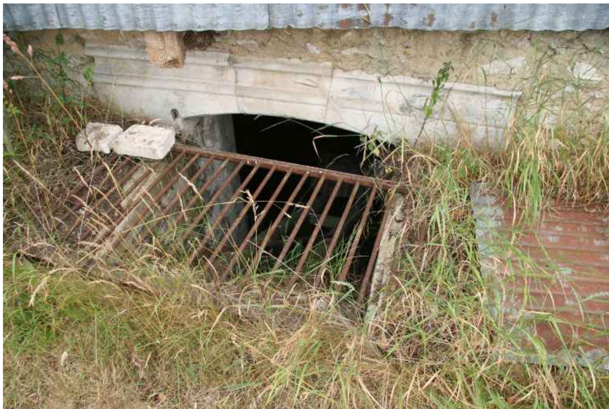
Soupirail du sous-sol du château démoli (pignon).
