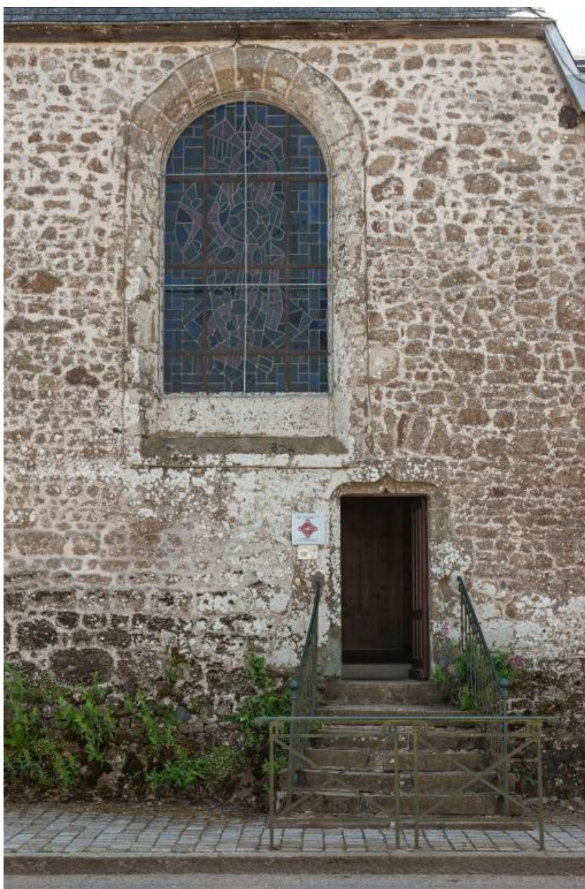
Chapelle nord-est : porte et fenêtre.
