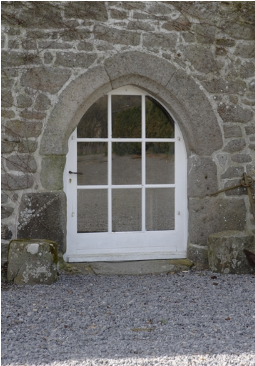
Façade nord. Rez-de-chaussée. Détail de la porte de la salle basse.
