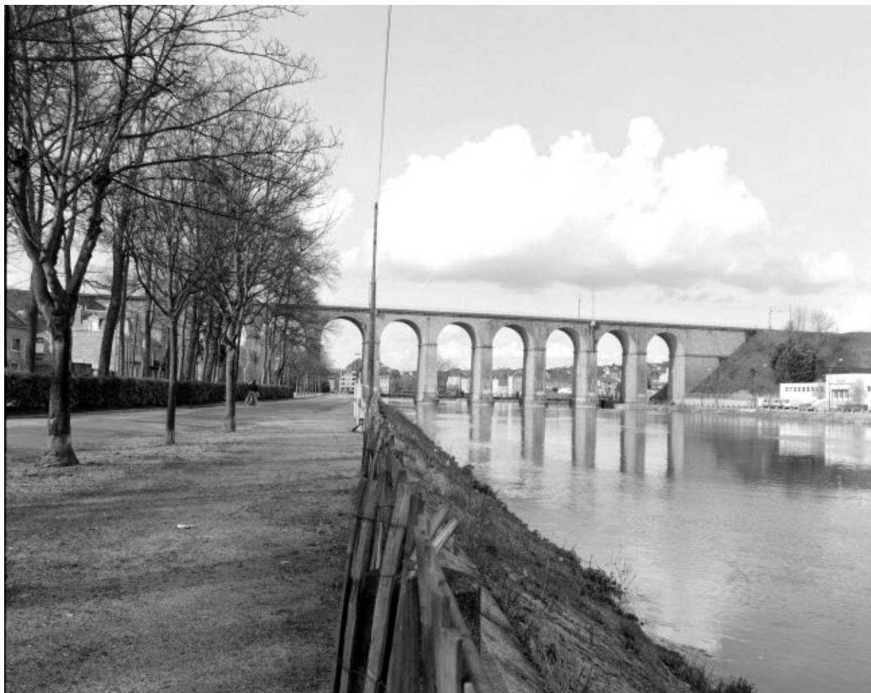
Vue d'ensemble du viaduc depuis la rive droite, en aval.
