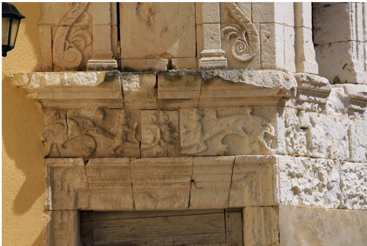
Tourelle d'escalier : linteau de la porte d'entrée.
