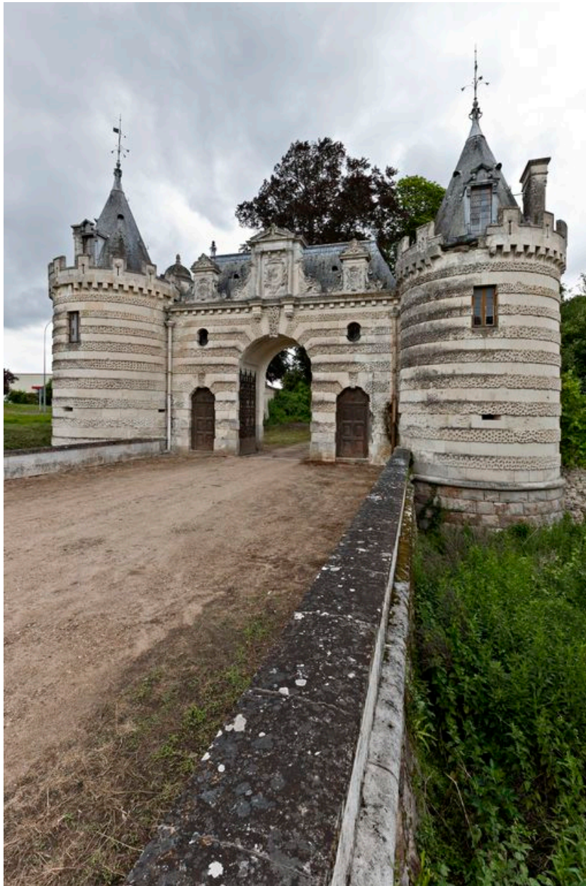
Les Tourelles : portail d'entrée du parc. A CHANGER REPARE
