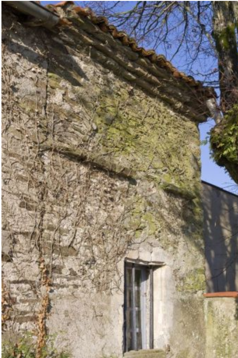
Le pigeonnier : détail des appareillages de pierres.
