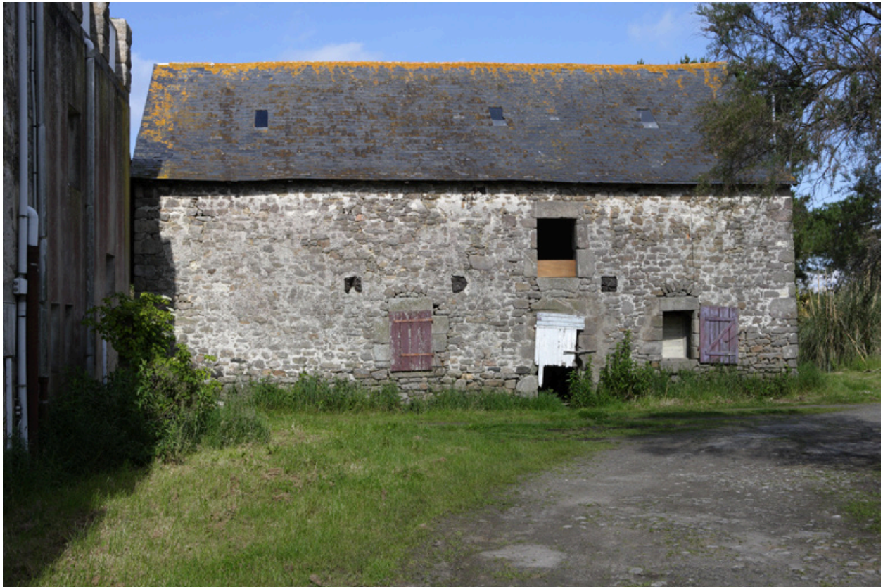
Dépendances. Vue de la façade est.
