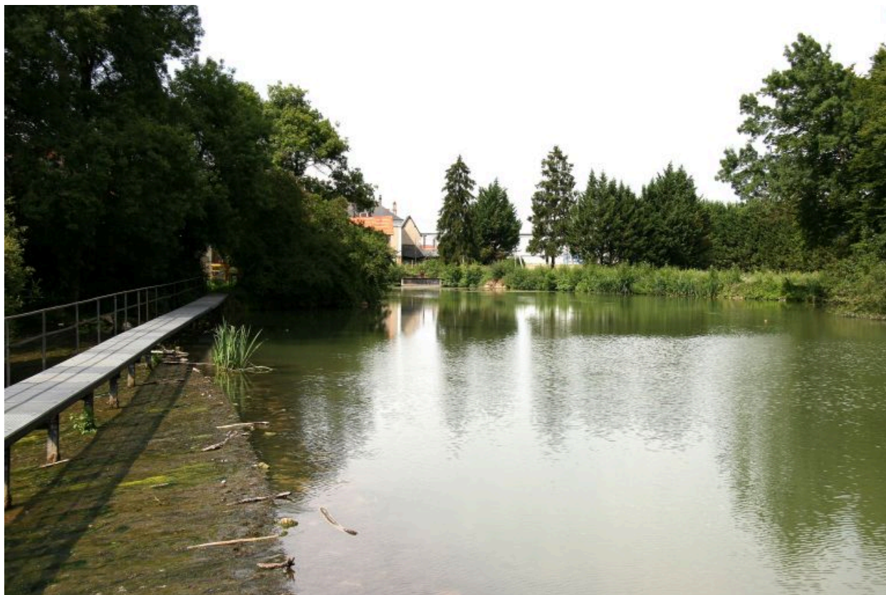
La chaussée depuis le barrage vers l'usine.
