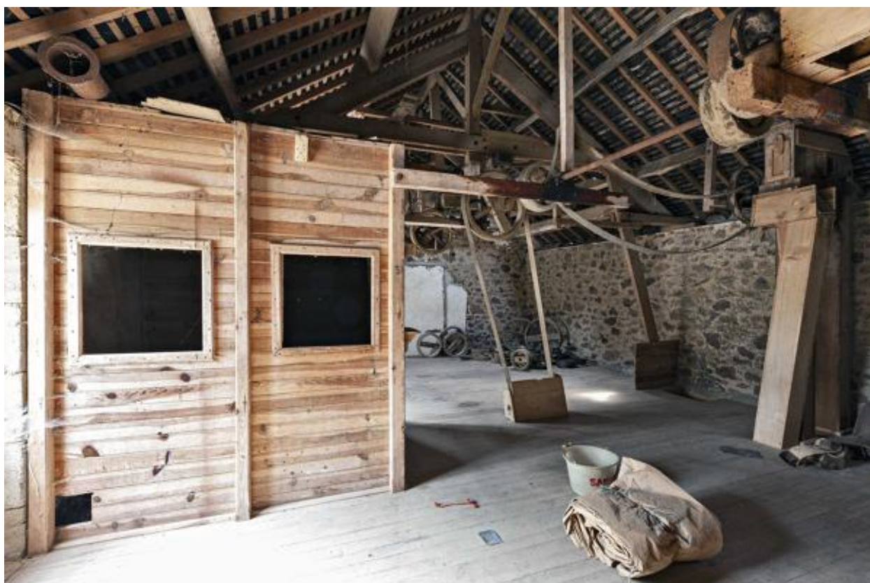
Magasin à farine, étage de comble.
