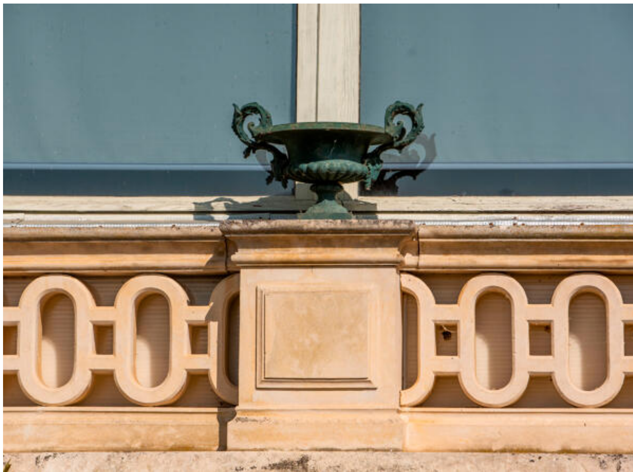
La galerie, détail d'un garde-corps.
