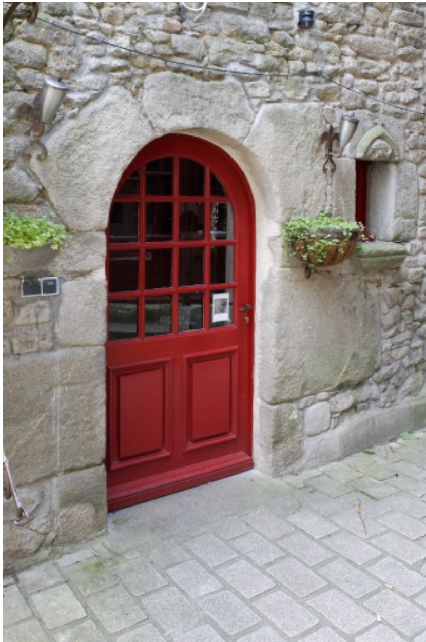
Façade principale, porte.
