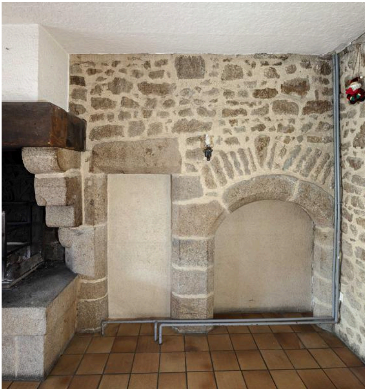
2-4 place du 8-Mai-1945, portes du mur de refend.
