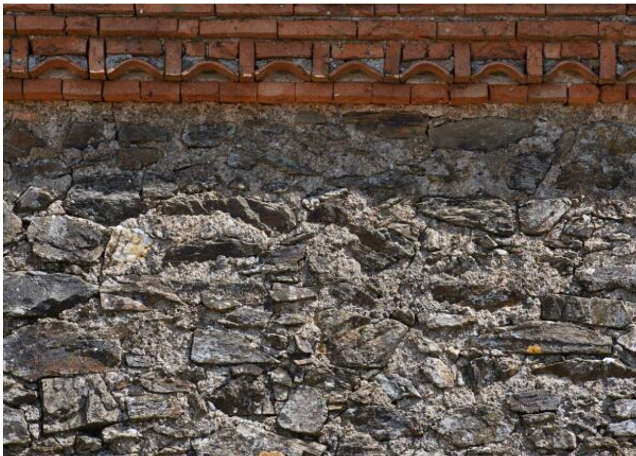
Façade ouest. Détail de la maçonnerie en moellons et de la corniche.
