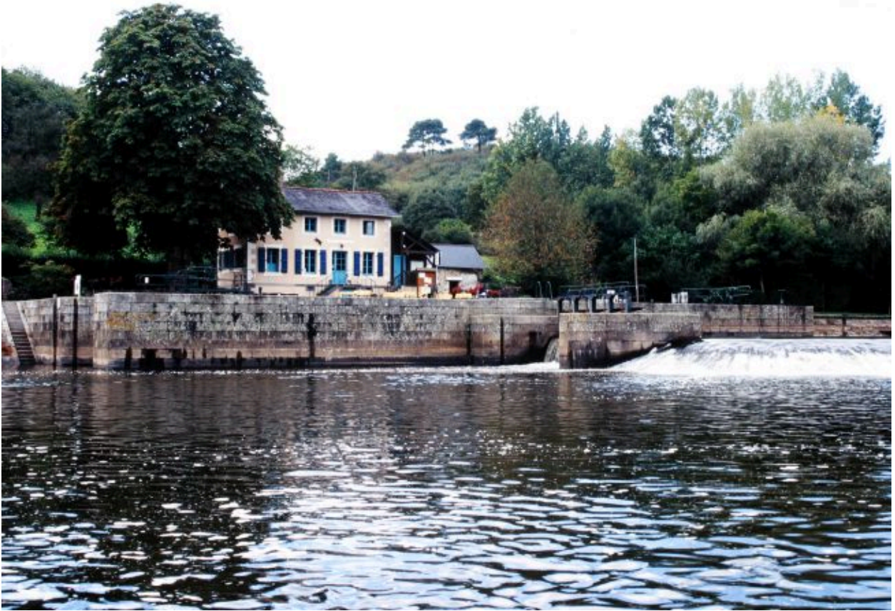
Vue de la maison éclusière, de l'écluse et du pertuis depuis la rive gauche.
