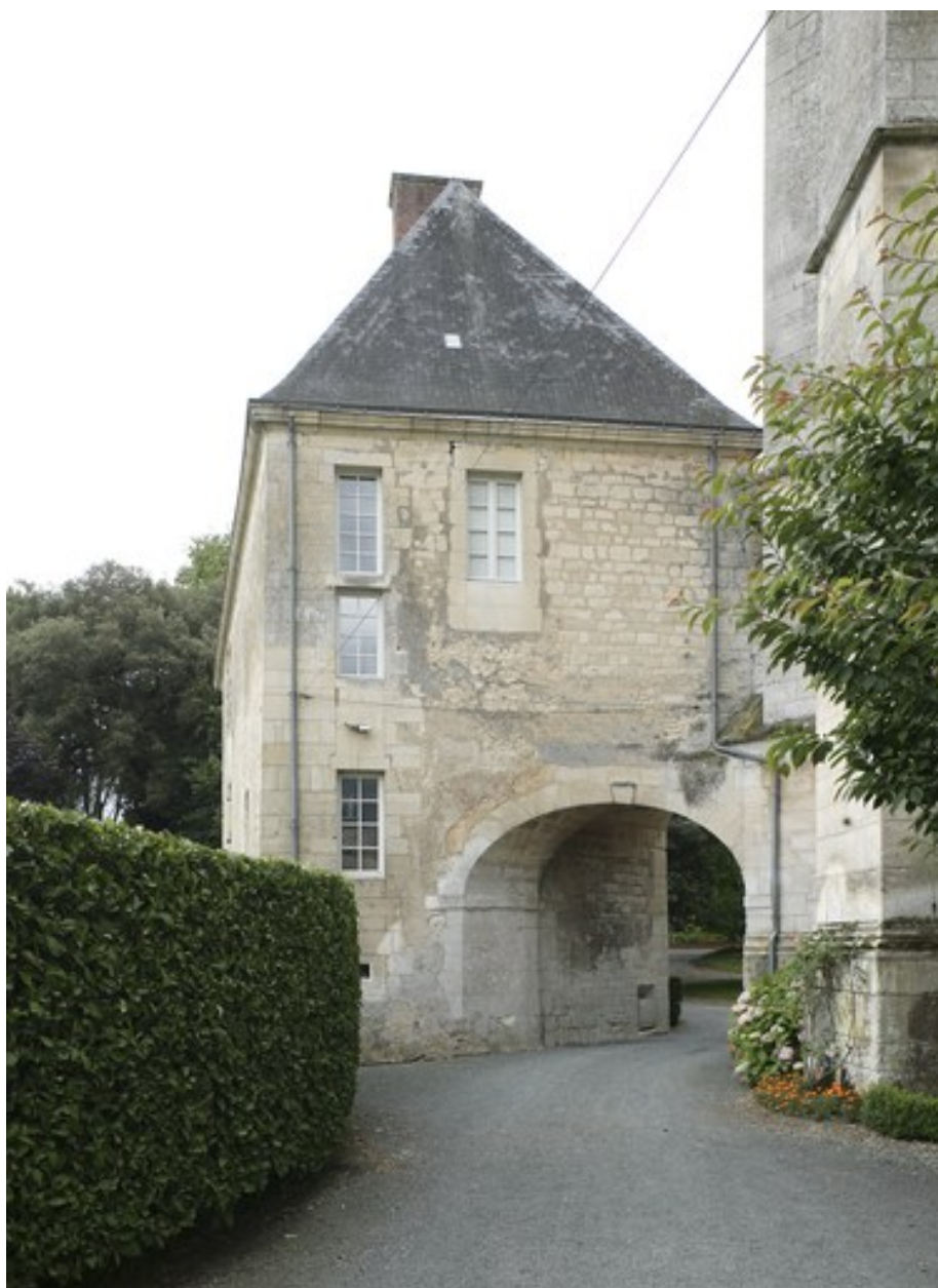
Bâtiment des archives : façade nord.
