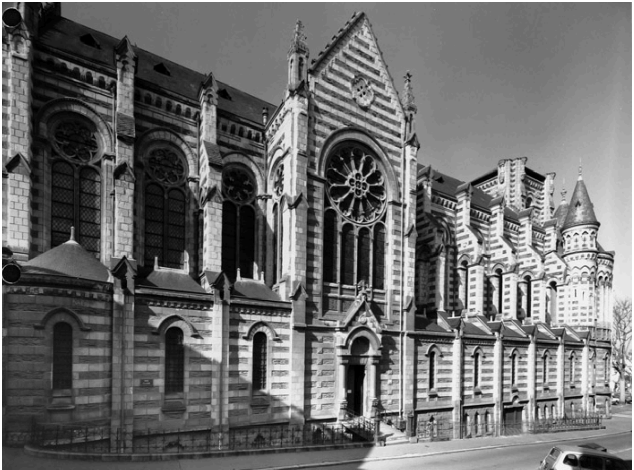
Façade latérale gauche (est).
