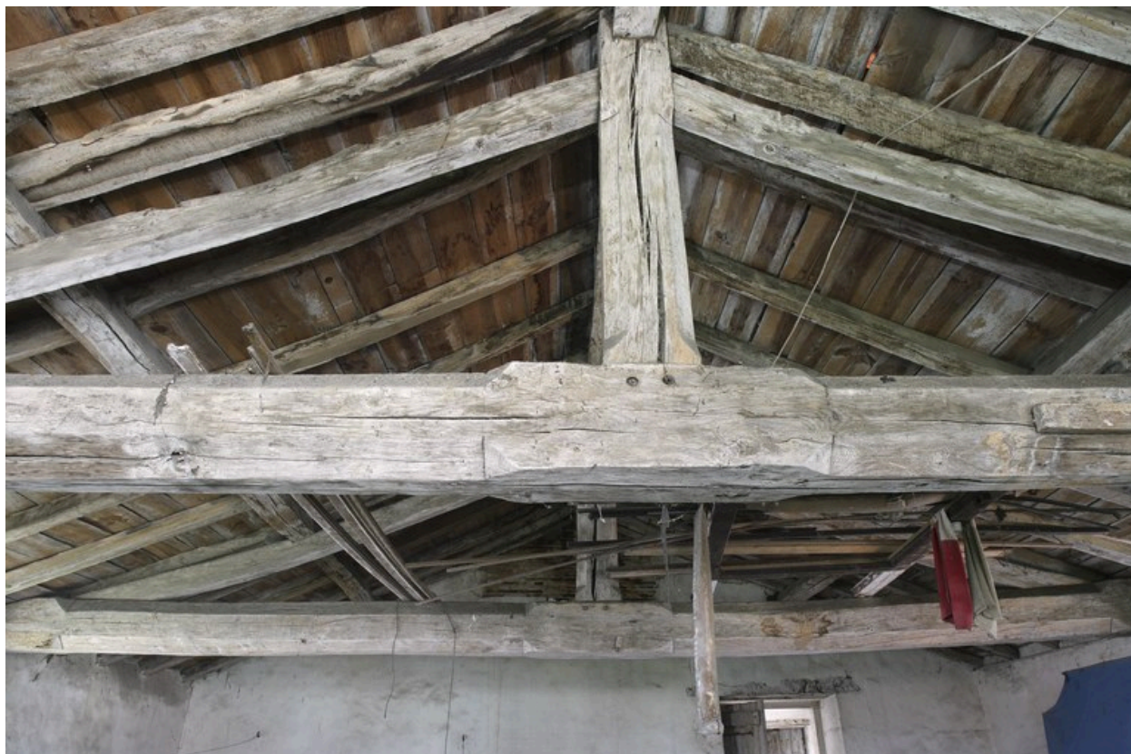
Vue de la charpente.
