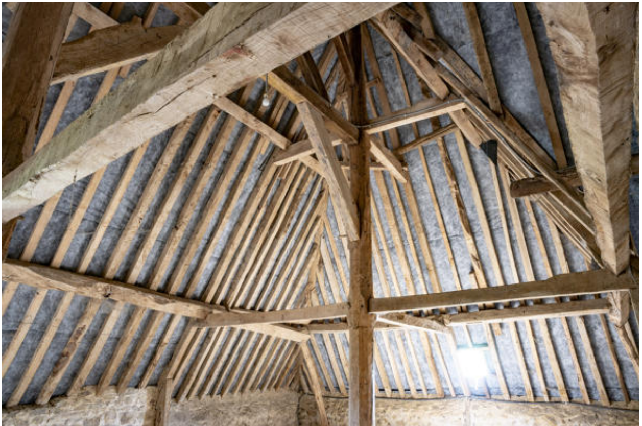
La charpente du pavillon.
