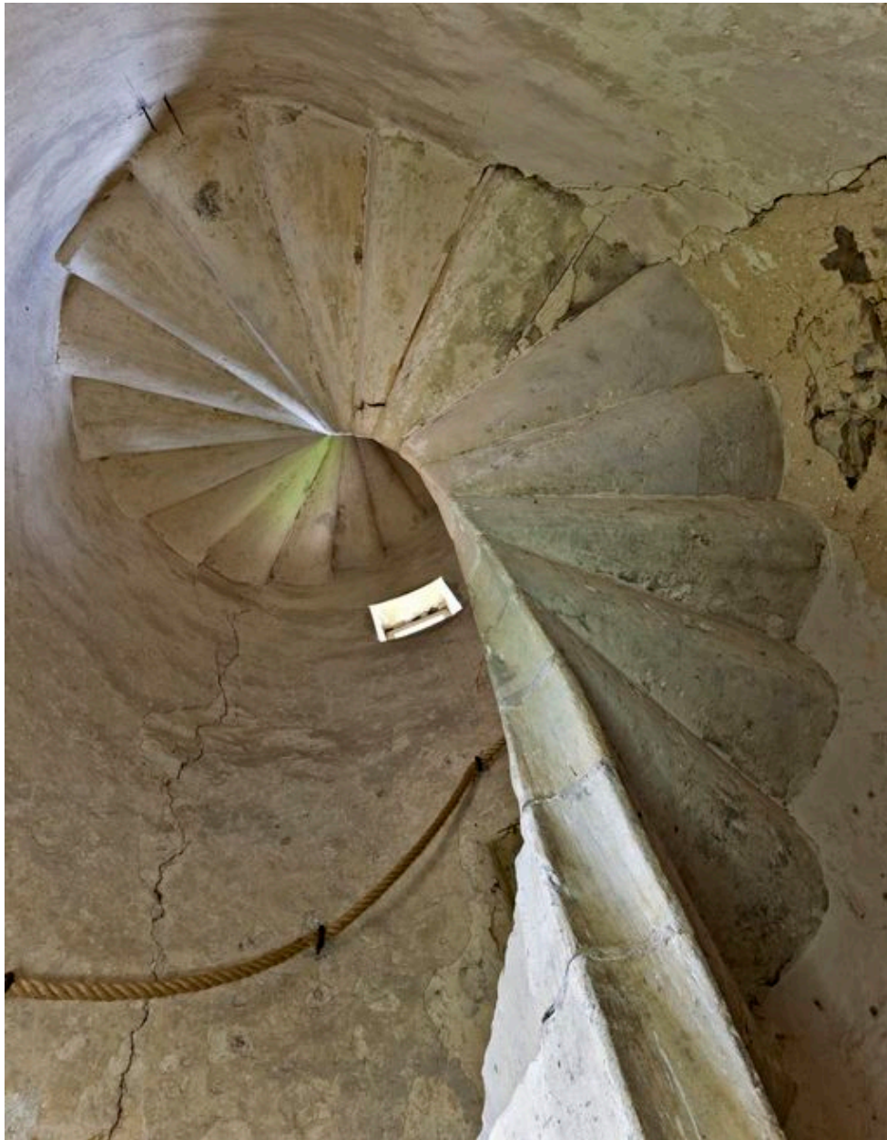
Vue de l'escalier en vis suspendu.
