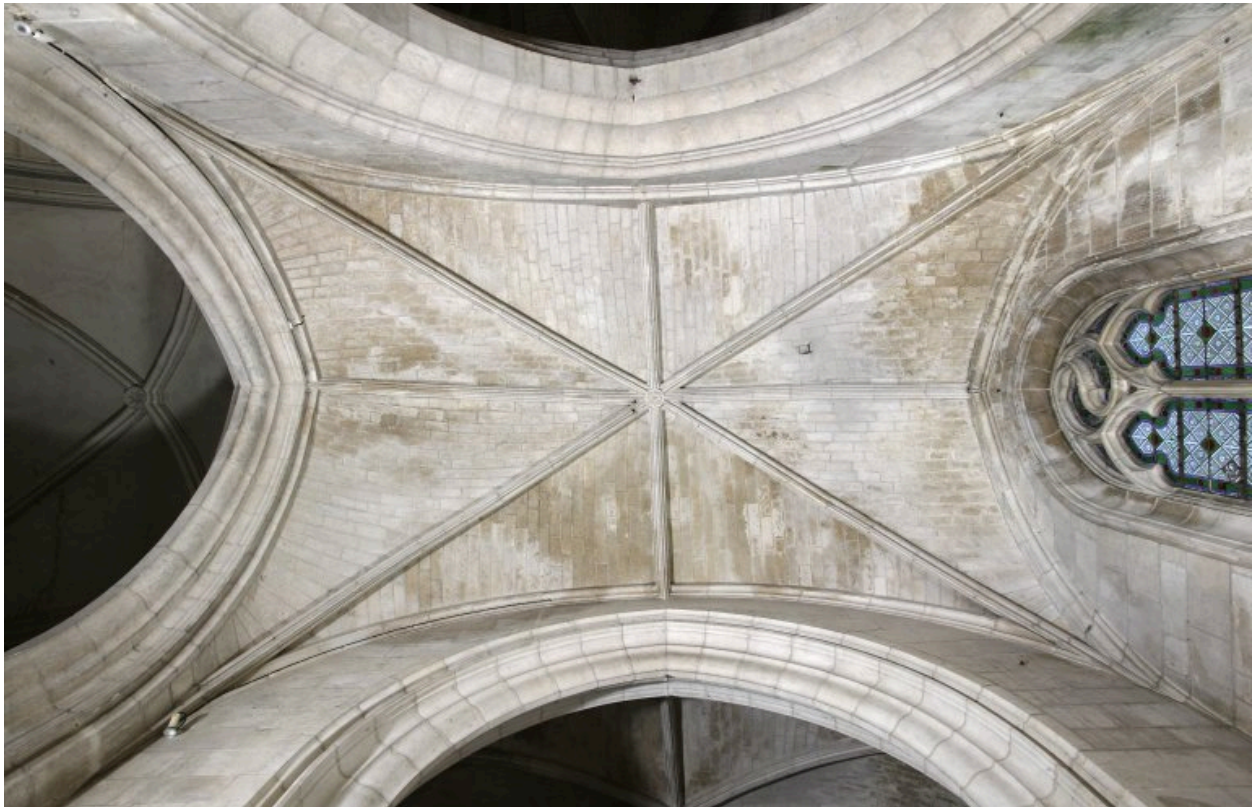
Cinquième chapelle du bas-côté nord de la nef : vue de la voûte.
