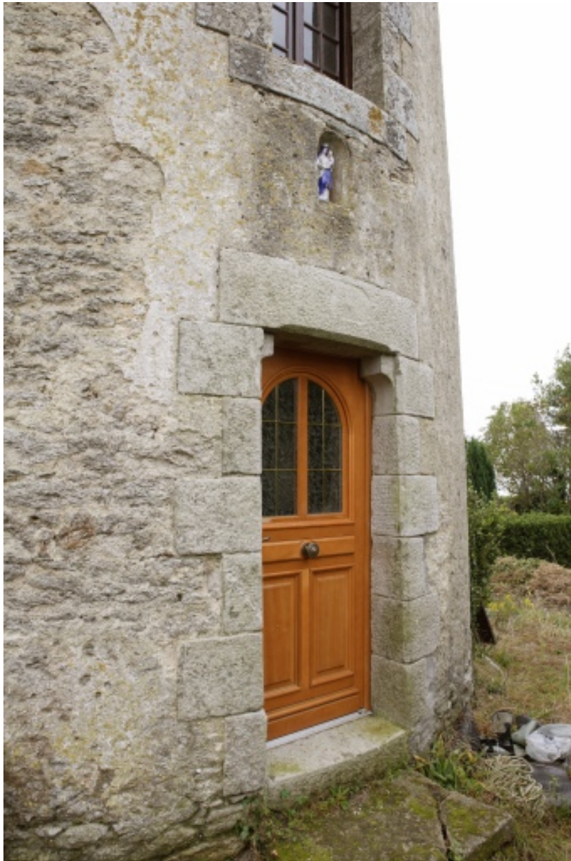
Rez-de-chaussée de la tour ; détail de la porte.
