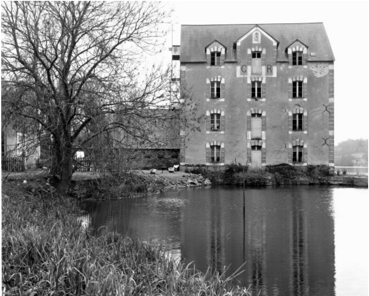
La façade nord (amont) de l'ancien et du nouveau moulin.
