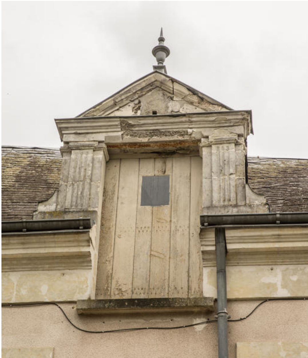
5, rue A. de Tocqueville, maison, détail : lucarne passante.
