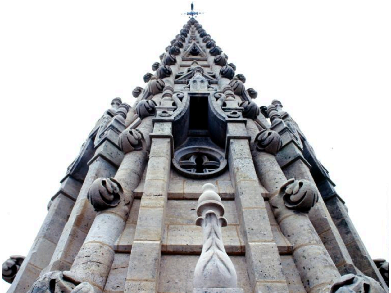
Basilique, clocher : détail de la flèche, partie haute.
