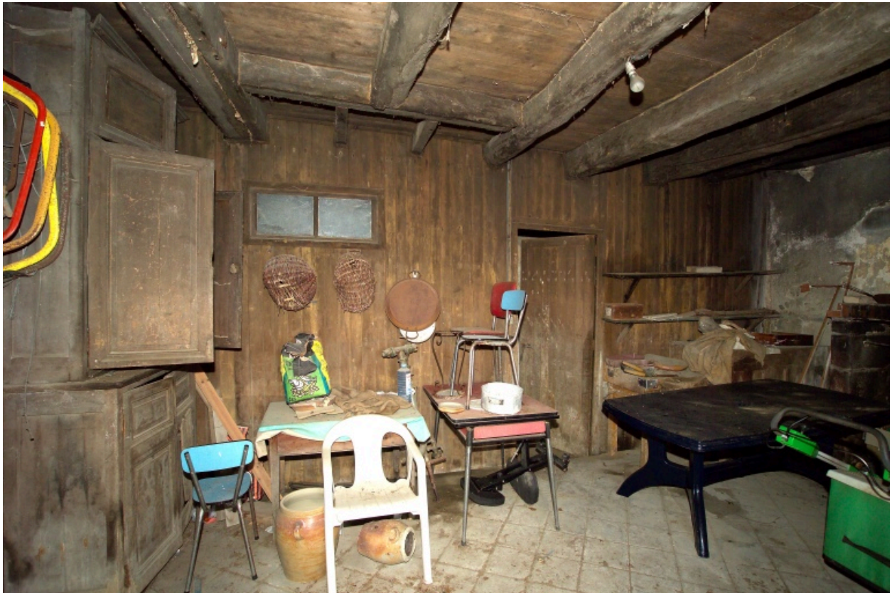
Rez-de-chaussée, cloison de bois.
